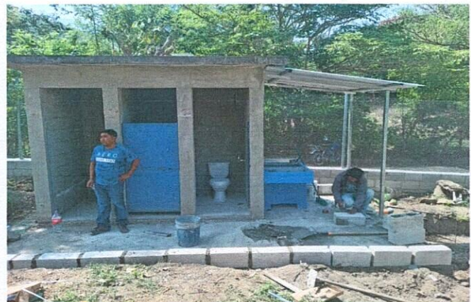
Foto 4: Mejoramiento de baños en la parte de atrás de la escuela en proceso (cambio de sanitarios, reparación de puertas, pintura, pila)
