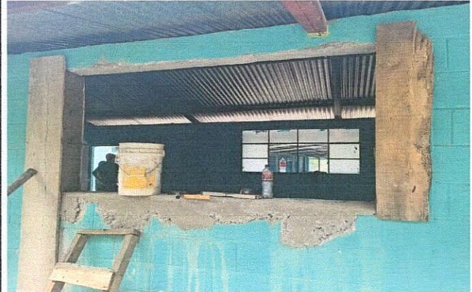
Foto 8: Mejoramiento de ventana en proceso para la colocación de ventana de PVC y balcon
